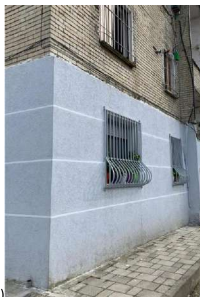
Fig. 6: Ndërtesë muraturë e dëmtuar, e përforcuar pas tërmetit të 8 Janarit 1988 a) faza e përforcimit strukturor, burimi EERI; b) e njëjta ndërtesë pas tërmetit të 26 Nëntorit 2019, foto nga M. Baballëku
